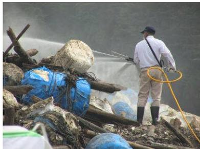
2日目、3日目の作業では農業用の噴霧器を使用して作業を行った。1回1.5tを3サイクル散布し、1日計4.5tの溶液を散布した。
