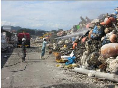
高圧洗浄車を使用し、1日目は約4000㎡の対象物に対して8tの溶液を散布した。
